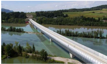
Drauquerung mit Ostportal Tunnel Lind im Hintergrund
