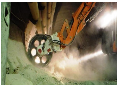
Vortunnel Südröhre Betonsohle schneiden
