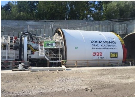
Start TVM Baugrube Mitterpichling
