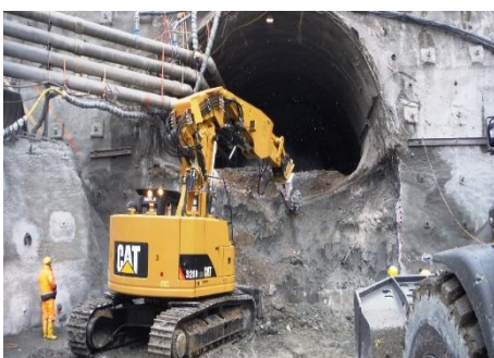
Mitterpichling Südvortrieb Herstellung Anschlagwand
