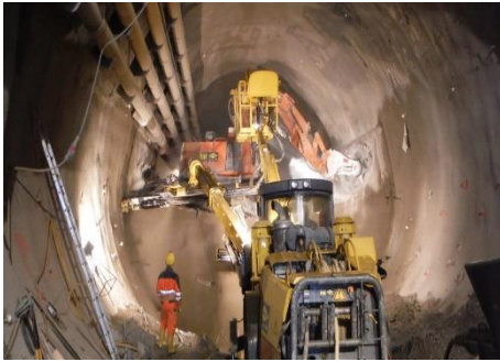
Vortunnel Südröhre Tunnelmeter 60
