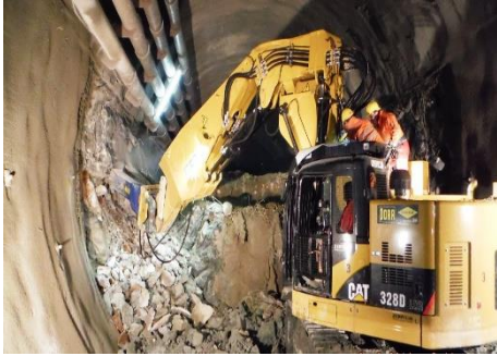
Mitterpichling Südvortrieb Tunnelmeter 30
