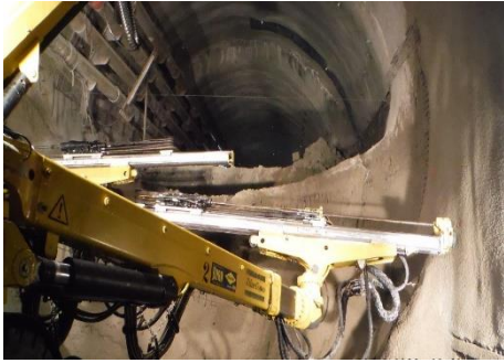
Mitterpichling Südvortrieb Ankerarbeiten
