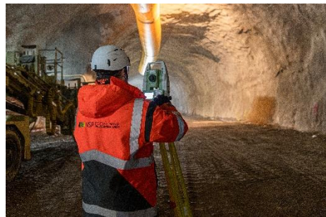
3D Verschiebungsmessungen Rampe Donau Süd
