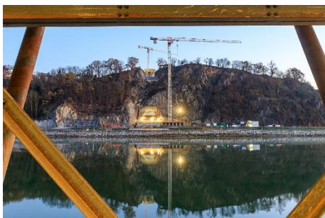
Sicht in Richtung Abspannpunkt Süd
