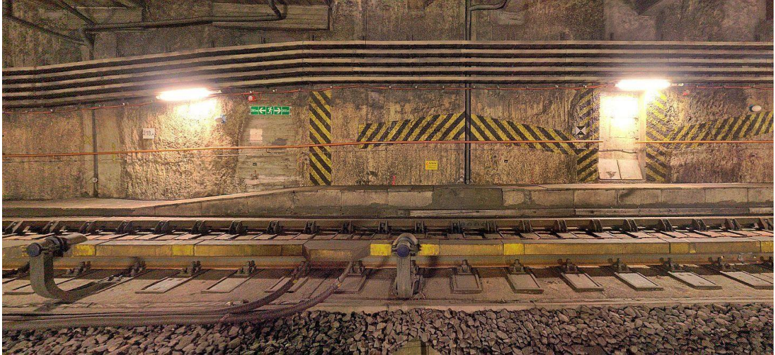
Vermessungsleistungen U-Bahnbau, Scanmessung
