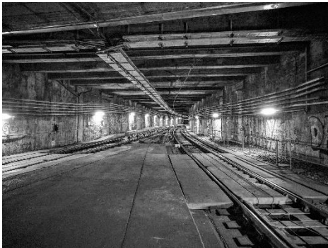
Absprungbauwerk U5 zweigleisiger Teil, Blickrichtung Station Rathaus
