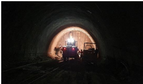
A11 Karawanken Autobahn, Karawankentunnel 2. Röhre Vortriebsarbeiten (ca. Tunnelmeter 1.070)
