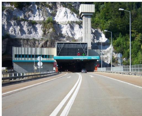
A11 Karawanken Autobahn, Karawankentunnel 2. Röhre Nordportal
