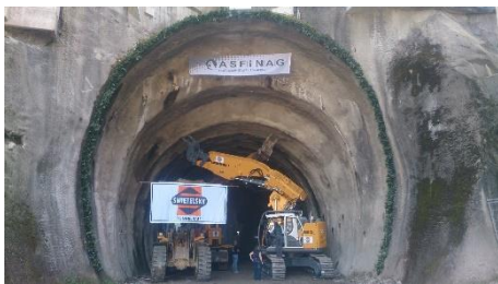
A11 Karawanken Autobahn, Karawankentunnel 2. Röhre Feierlicher Beginn der Vortriebsarbeiten am 18.09.2018
