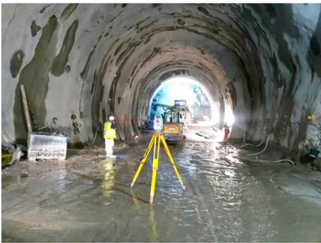
Vortrieb Zugangsstollen Kavernenkrafthaus (Rohrschirm)
