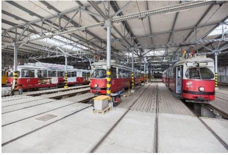
Remise Brigittenau, Halle 1
