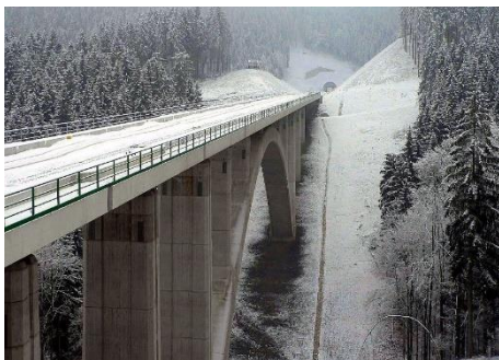
Portal Tunnel Goldberg Nord und Dunkeltalbrücke
