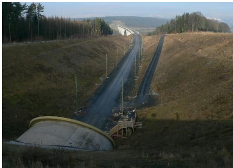
Portal Tunnel Müss Nord über Grümpentalbrücke bis Portal Tunnel baumleite Süd
