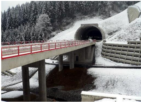
Portal Tunnel Blessberg Nord und Saubachbrücke
