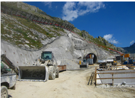
Portal Zugangsstollen Schoberboden
