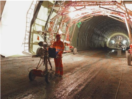
Tunnelscan vor Aufbringen der Isolierung
