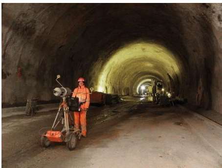
Tunnelscan nach Abklingen der Verformungen
