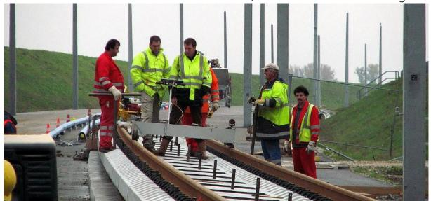
Vermessung Bahnbau und U-Bahnbau, Vermessung Feste Fahrbahn
