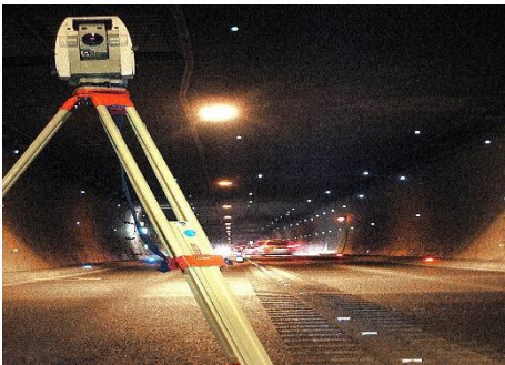
3D-Verschiebungsmessung bei halbseitiger Tunnelsperre
