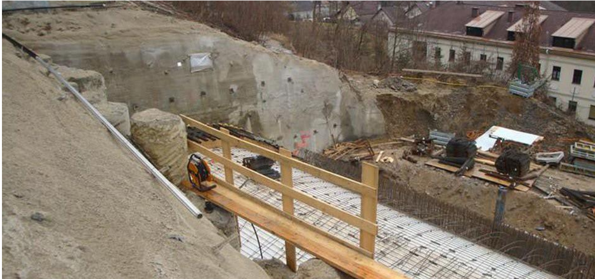
Vermessung Tunnelbau, Scanmessung
