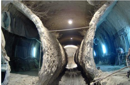
2-gleisiger Bereich (Ulmenstollenvortrieb)
