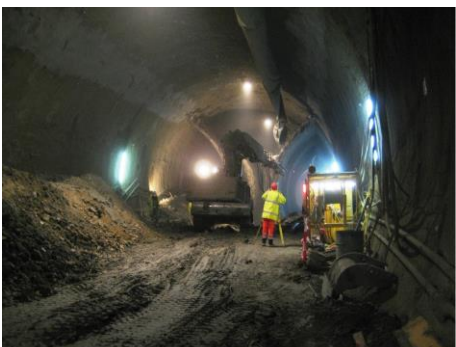
2-gleisiger Bereich (Ulmenstollenvortrieb) 3D-Verschiebungsmessung
