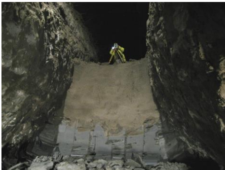
2-gleisiger Bereich (Ulmenstollenvortrieb) 3D-Verschiebungsmessung im Kern
