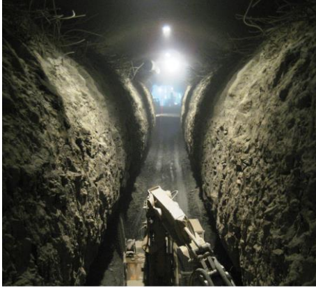
2-gleisiger Bereich (Ulmenstollenvortrieb)
