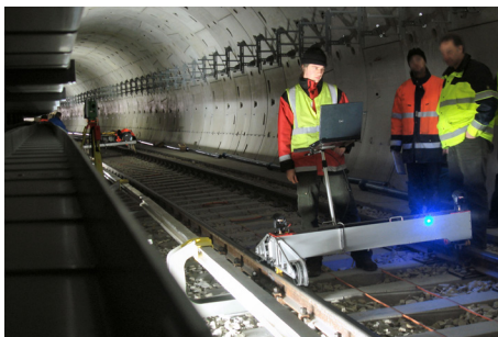
Gleislagekontrolle U-Bahn Wien, Verbindungsgleis Betriebsbahnhof Erdberg - U2/5 Stadion
