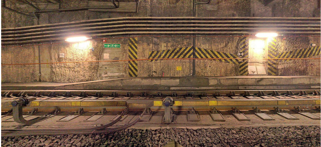
Vermessungsleistungen U-Bahnbau, Scanmessung
