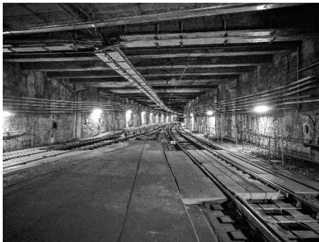
Absprungbauwerk U5 zweigleisiger Teil, Blickrichtung Station Rathaus
